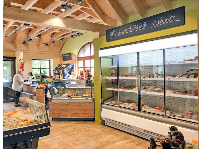
Türen vor dem Kühlregal sind zunehmend Standard. Dadurch lassen sich zwischen 20 und 35 % Energie sparen.
