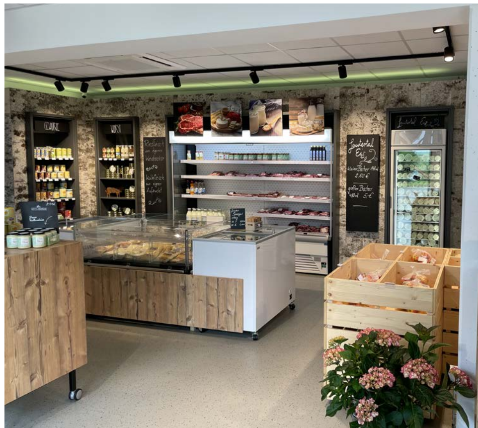
Regale sowie Kühlmöbel sind hinter einer Vorwand als Nische in die Wand eingebaut und durch Blenden eingerahmt. Hinter den Tafeln verbergen sich Vorratsschränke.
